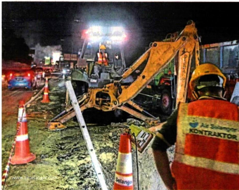
雪州水供公司已完成第二中環公路水管破裂的維修工作。
